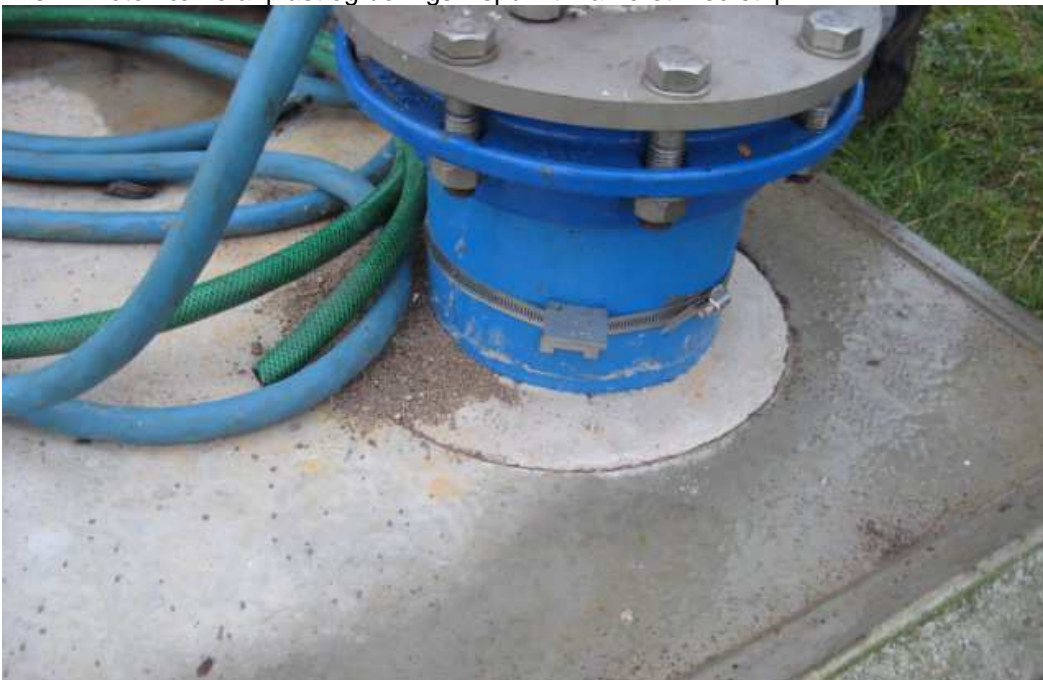
Eks. 2: Kotemærke af metal og påsat med spændebånd. Boringsfikspunkt ved den vandrette metalplade.
